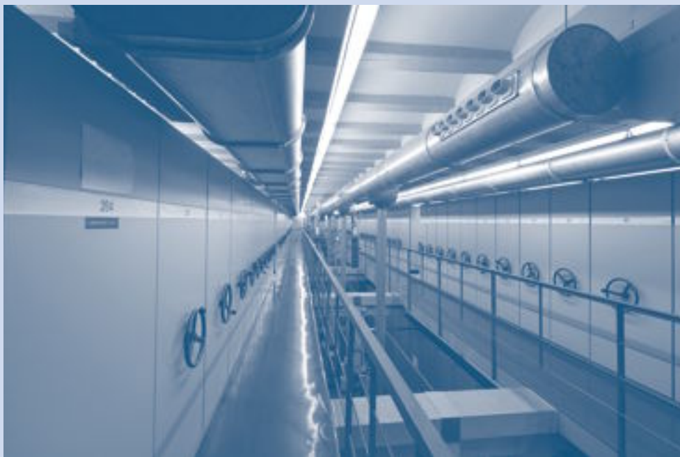
Instalaciones del Archivo
