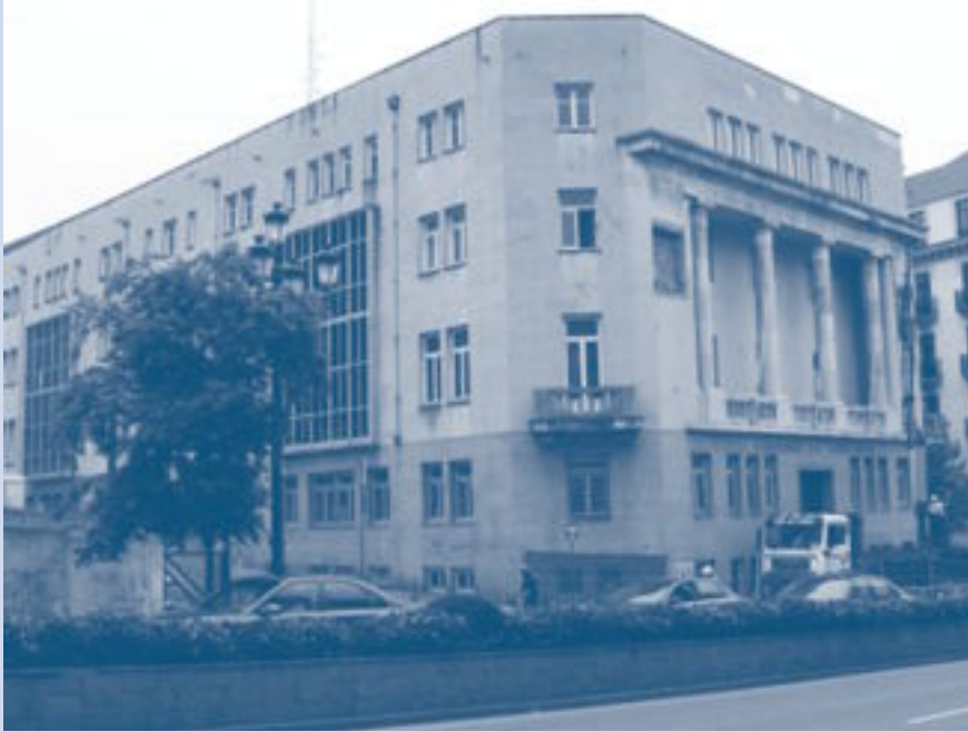
Palacio regional, sede del Gobierno de Cantabria, en víspera de su derribo, en mayo de 2009
