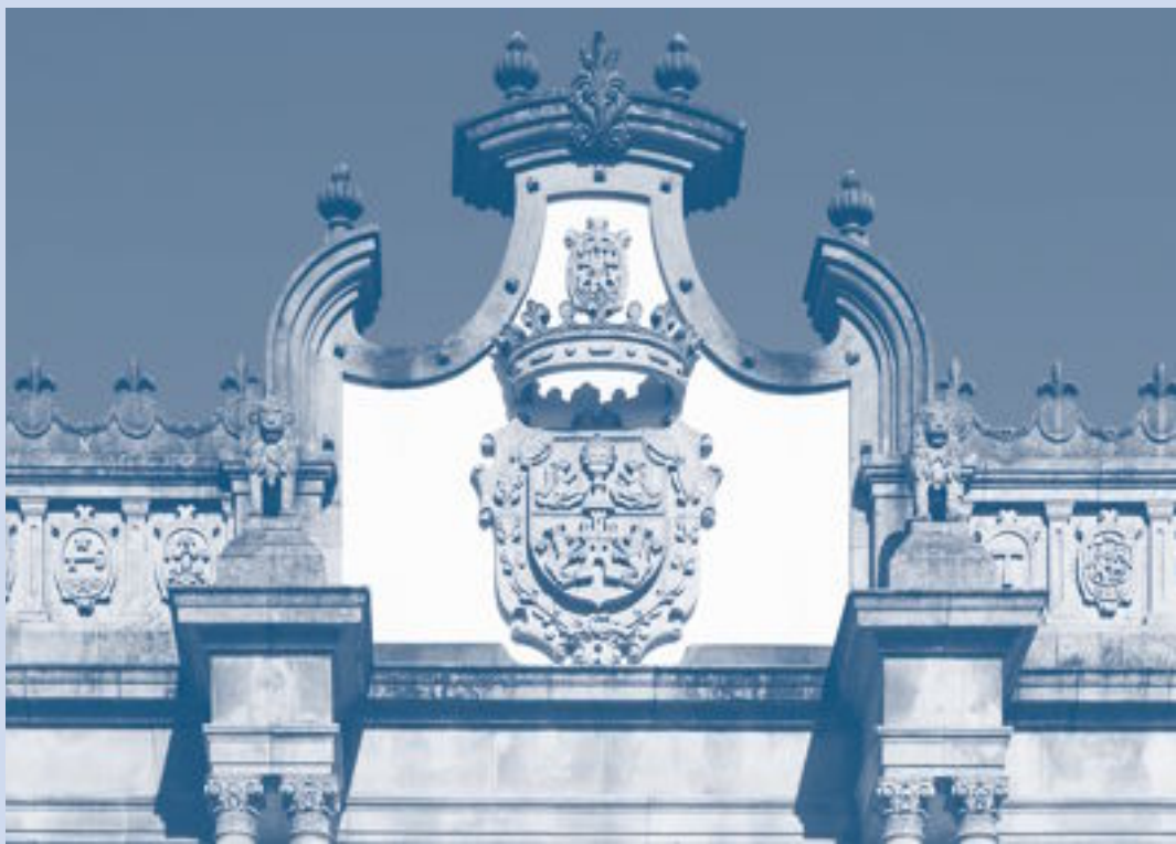
Pazo de San Marcos. Edificio da Deputación de Lugo
