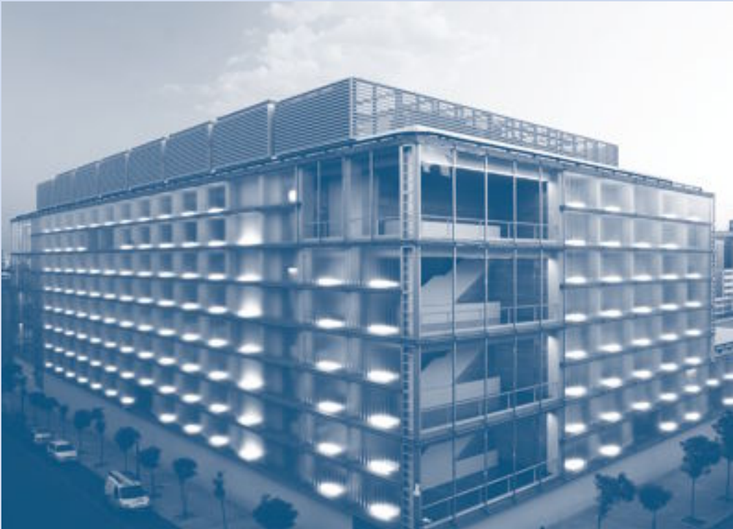
Edificio Depósito ARCM. Complejo El Águila.
